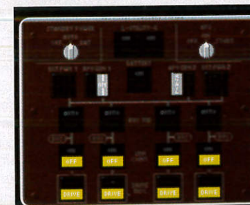
Écran 4. L'APU a démarré, la génératrice est déjà sur le bus de gauche.
